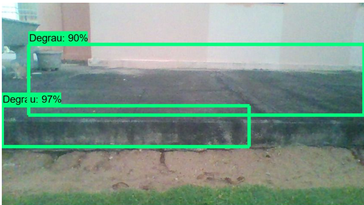
Figura 21 Imagem da parte frontal do degrau, com baixa iluminação.
