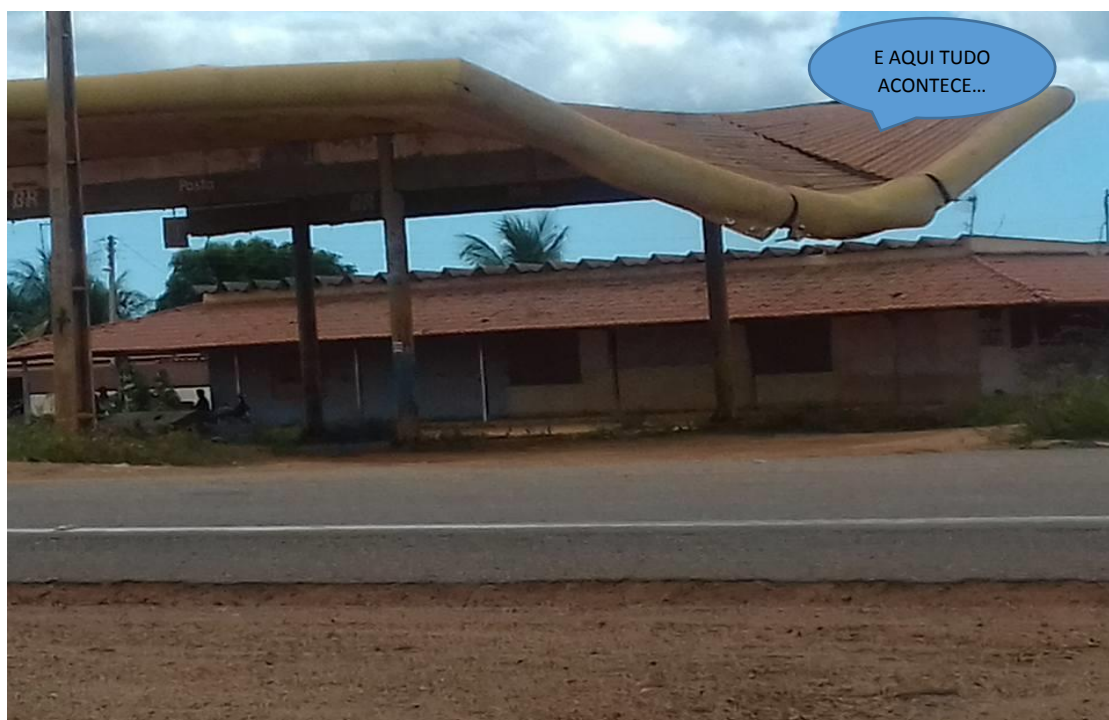
Figura 12: Posto de gasolina desativado – Espaço da Escola Cacimba Funda
