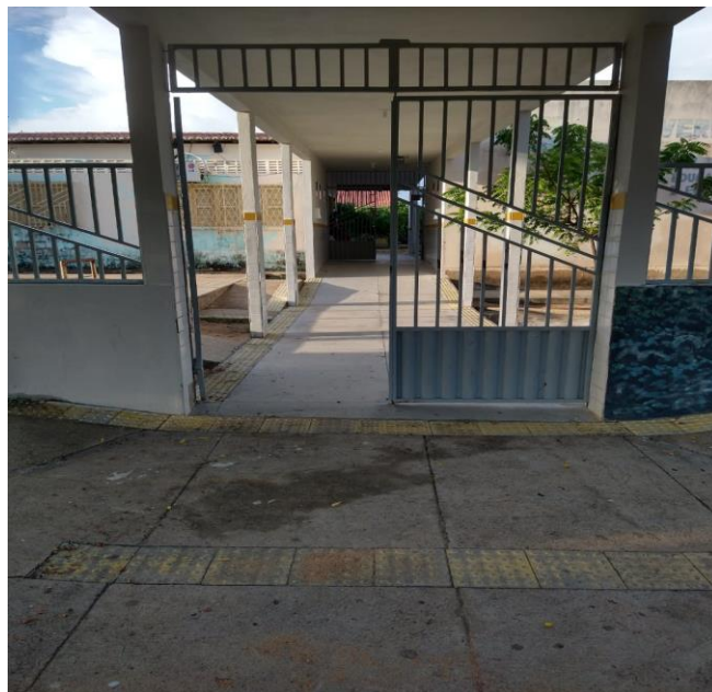
Figura 7: Portão de entrada.
