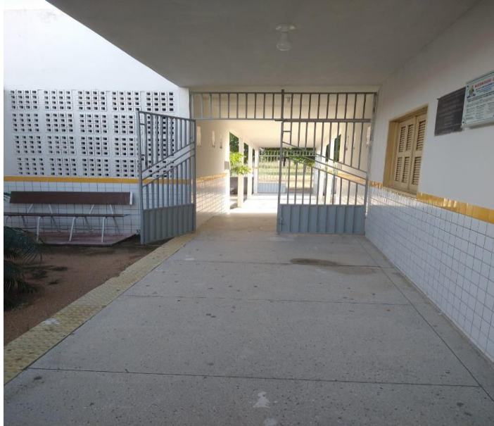
Figura 8: Portão de entrada.
