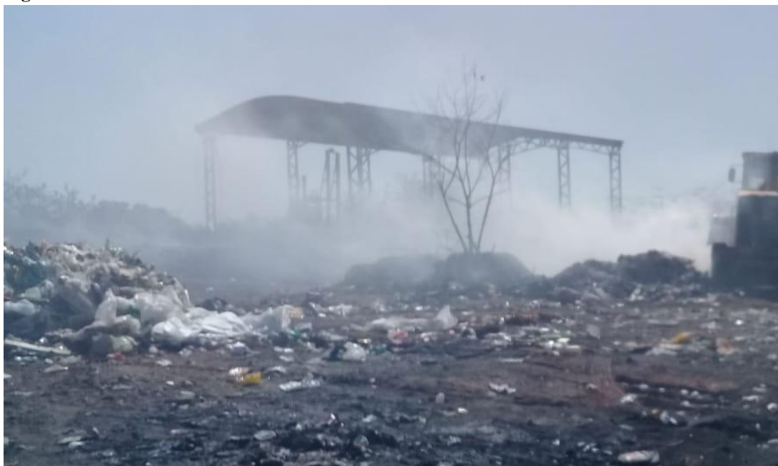
Figura 4 – Incêndio ocorrido em setembro de 2019 na COOPERACREVI.
