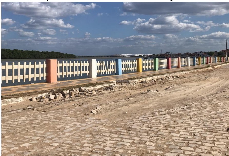
Foto 01: Calçamento na Orla de Porto do Mangue
