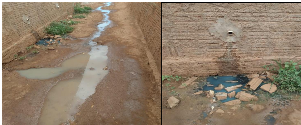
Figura 16 – Pontos de esgoto doméstico na Comunidade de Cacimba Funda
