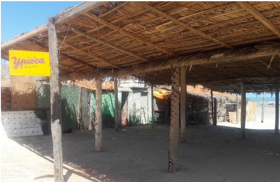
Figura 06 – Banheiros próximos à faixa de praia - Praia de Baixa Grande Foto: Erika Souza (2018)
