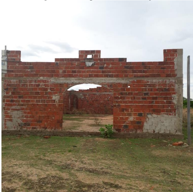
Figura 10 - Capela em construção
