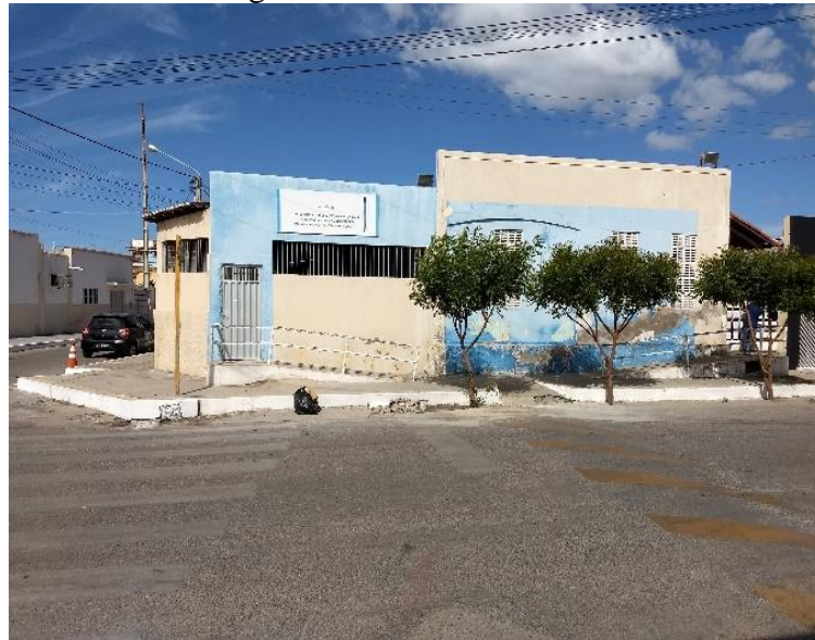
Figura 2 – Fachada da escola.
