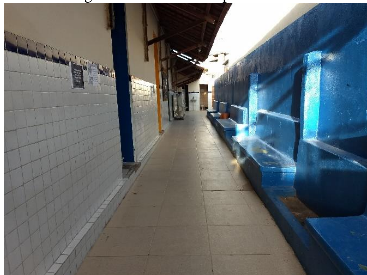
Figura 7 – Corredor do prédio matriz.
