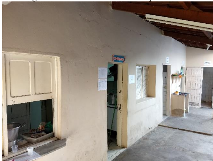
Figura 11 - Cozinha da escola no prédio anexo.
