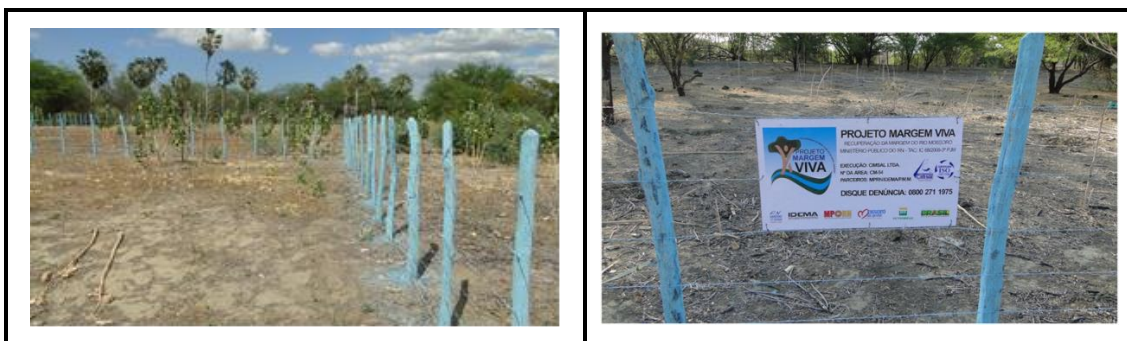
Figura 3: Cerca construída em torno da área, com pintura das estacas para evitar roubo.
