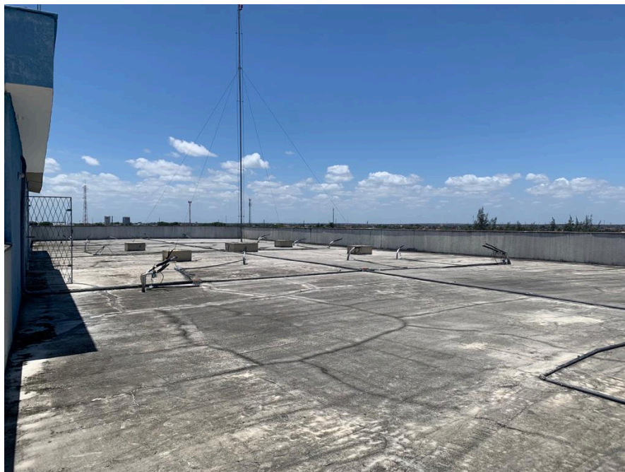
Figura 9: Teto do prédio lado B
