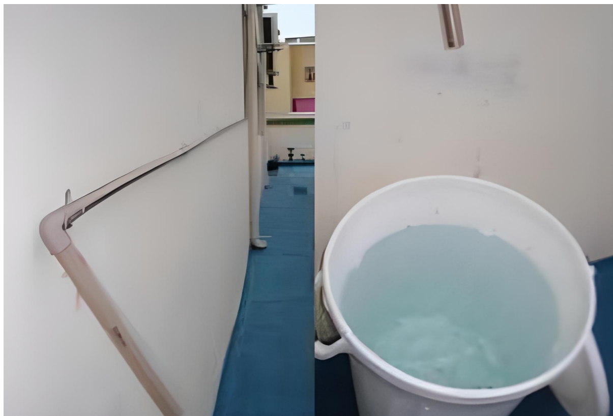
Figura 14 - Conexão da encanação ao e recipientes de armazenamento
