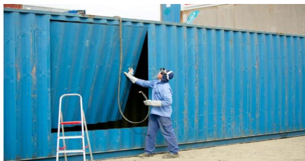
Figura 9: Corte em container.
