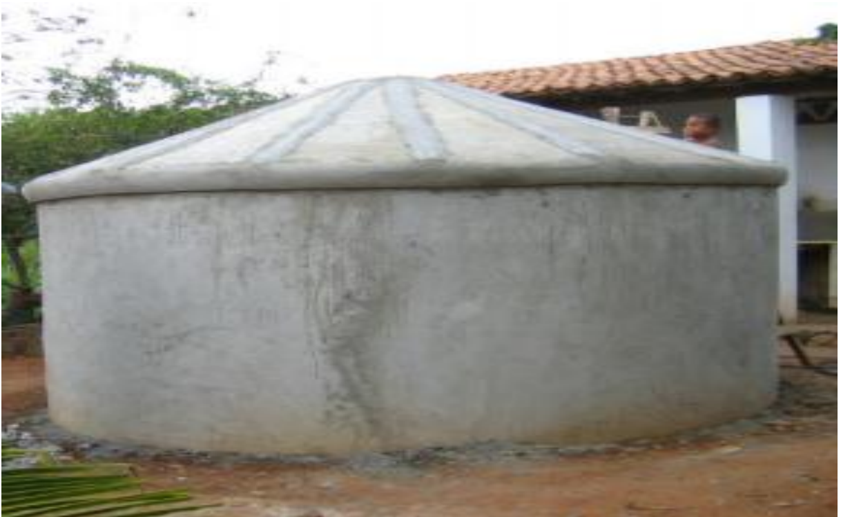
Figura 7: Estrutura final da cisterna
