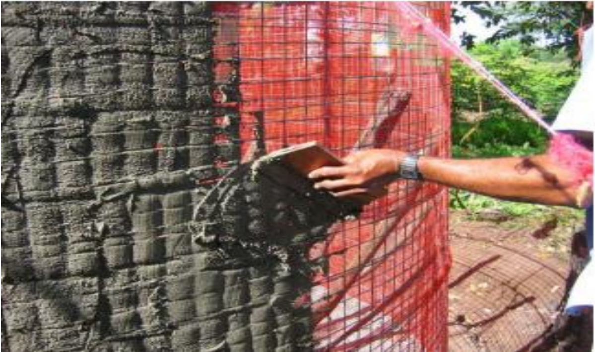
Figura 6: Construção da cisterna
