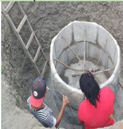
Figura 15 - Tanque Séptico ou decantador
