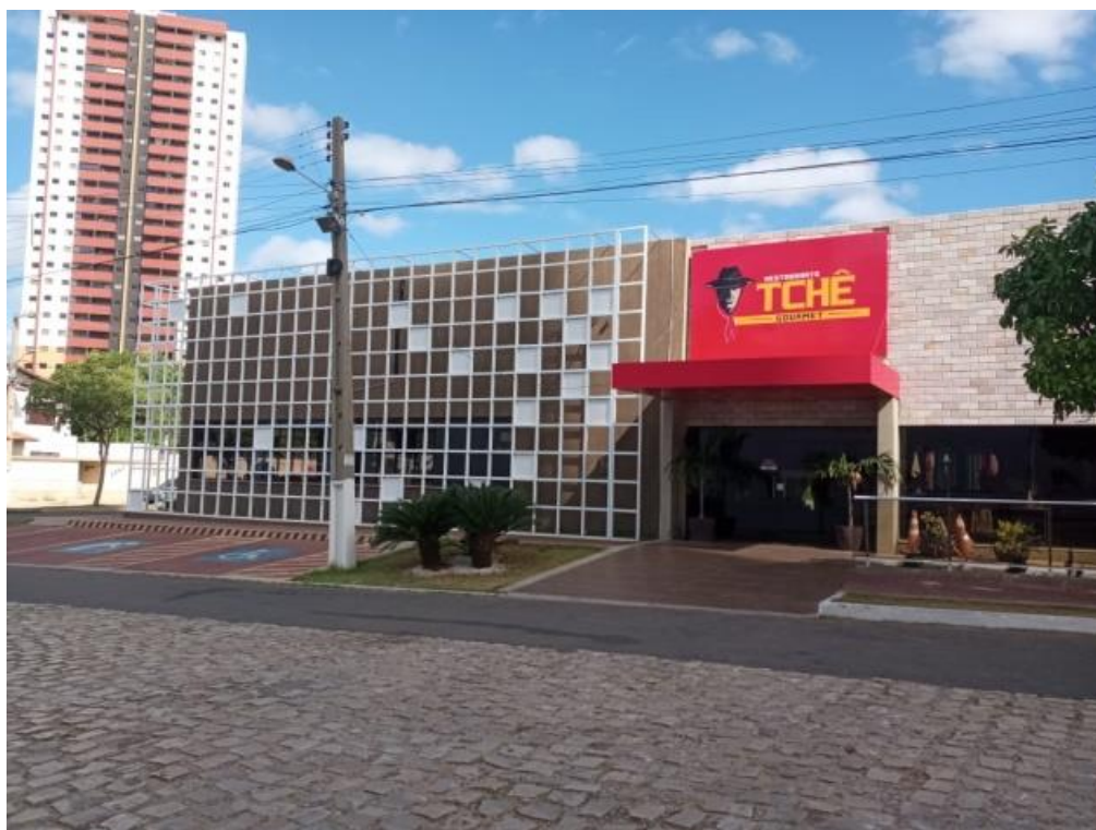
Figura 8 – Estabelecimento Tchê Gourmet adjacente a Avenida João da Escóssia
