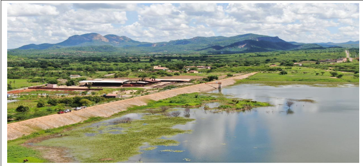
Figura 4 - Vista aérea do Açude Lucrécia, maciço 02 e tomada d'água.
