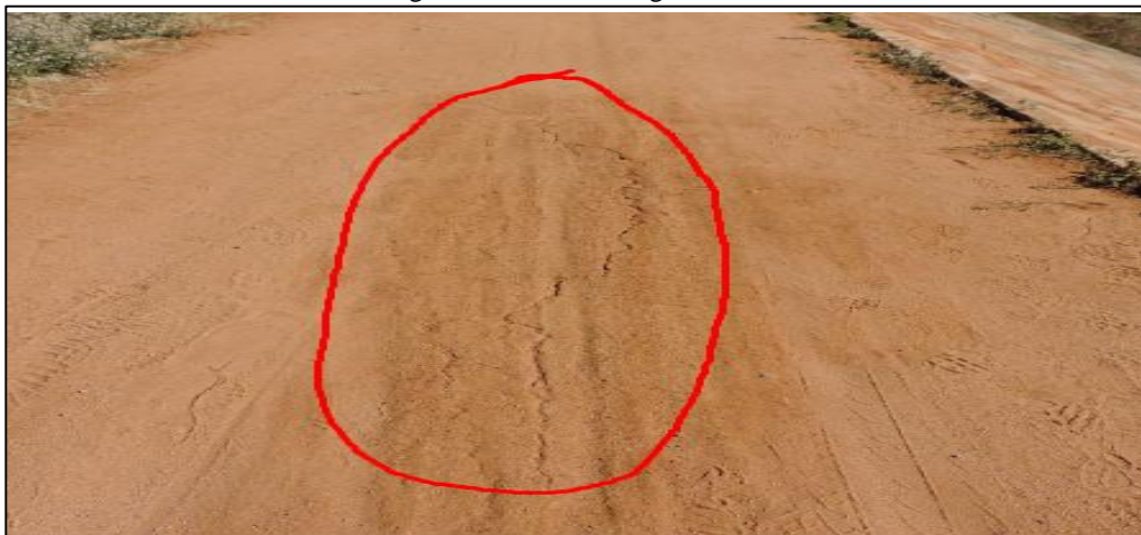
Figura 12: Trincas longitudinais
